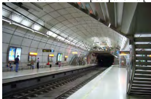
Рис.8. Станция в метро
