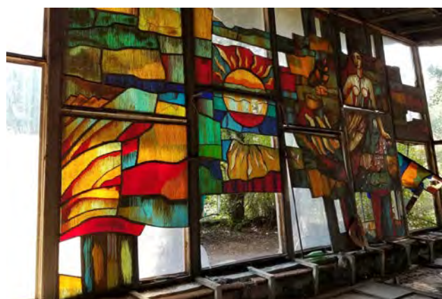
Рис. 6. Торцевой витраж с открытой гранью. Фрагмент. 1970-е гг. Стекло, металл. Кафе «Припять». Припять, Украина. Фотоархив
