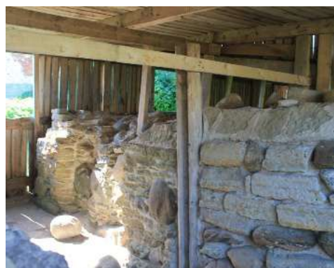
Рисунок 6. Фундамент из трех рядов валунов Figure 6. Foundation of three rows of boulders
